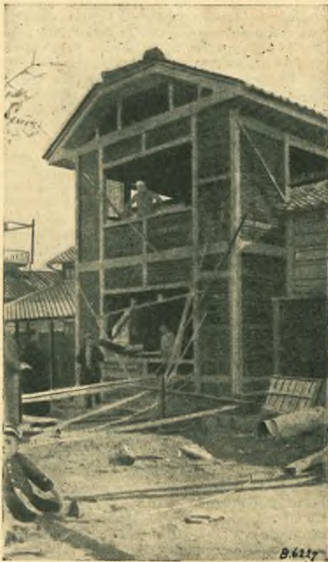
Oita (Giappone). — Asilo infantile in costruzione.
